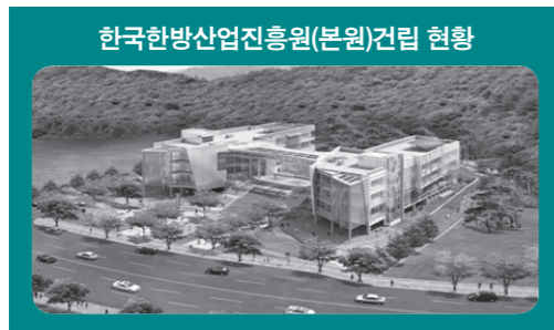
〈그림 4-8〉 한국한방산업진흥원 부지 및 건물
